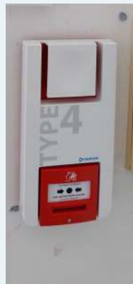
Installation d'une alarme incendie sur l'ensemble du groupe scolaire et pose de détecteurs de fumée dans la cantine reliés aux logements communaux situés à l'étage
