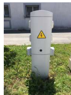
Pose d'un coffret forain (4 prises 220V et 2 prises 380 V)
