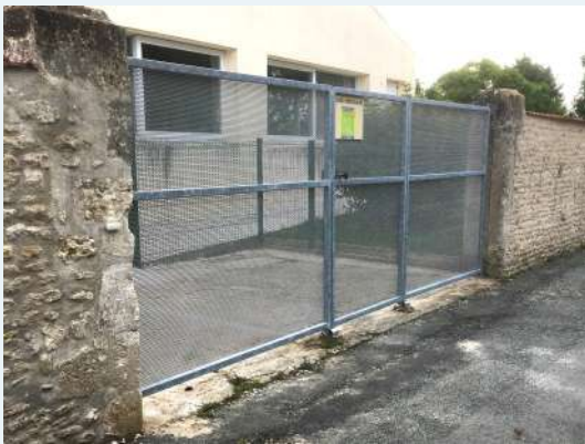
Changement du portail avec pose d'une gâche électrique
