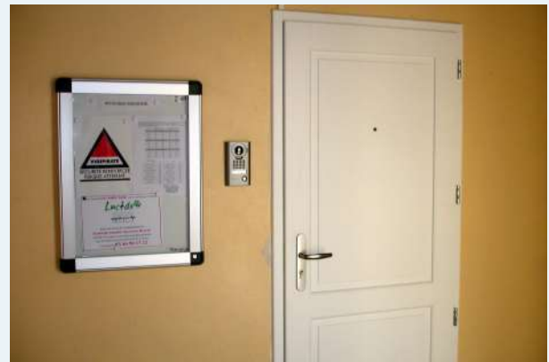
Changement de la porte du sas d'entrée, pose d'une grille de sécurité et d'un visiophone
