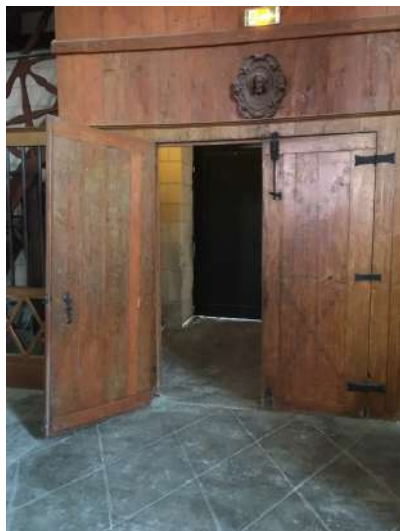
Exemples de travaux : retournement des portes du sas d'entrée et dégagement de l'issue de secours de la sacristie (normes sécurité incendie)
