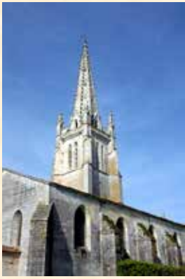
Eglise travaux de réhabilitation du plafond
