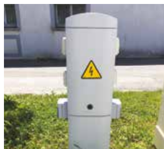
Après. Pose d'un nouveau coffret forain
