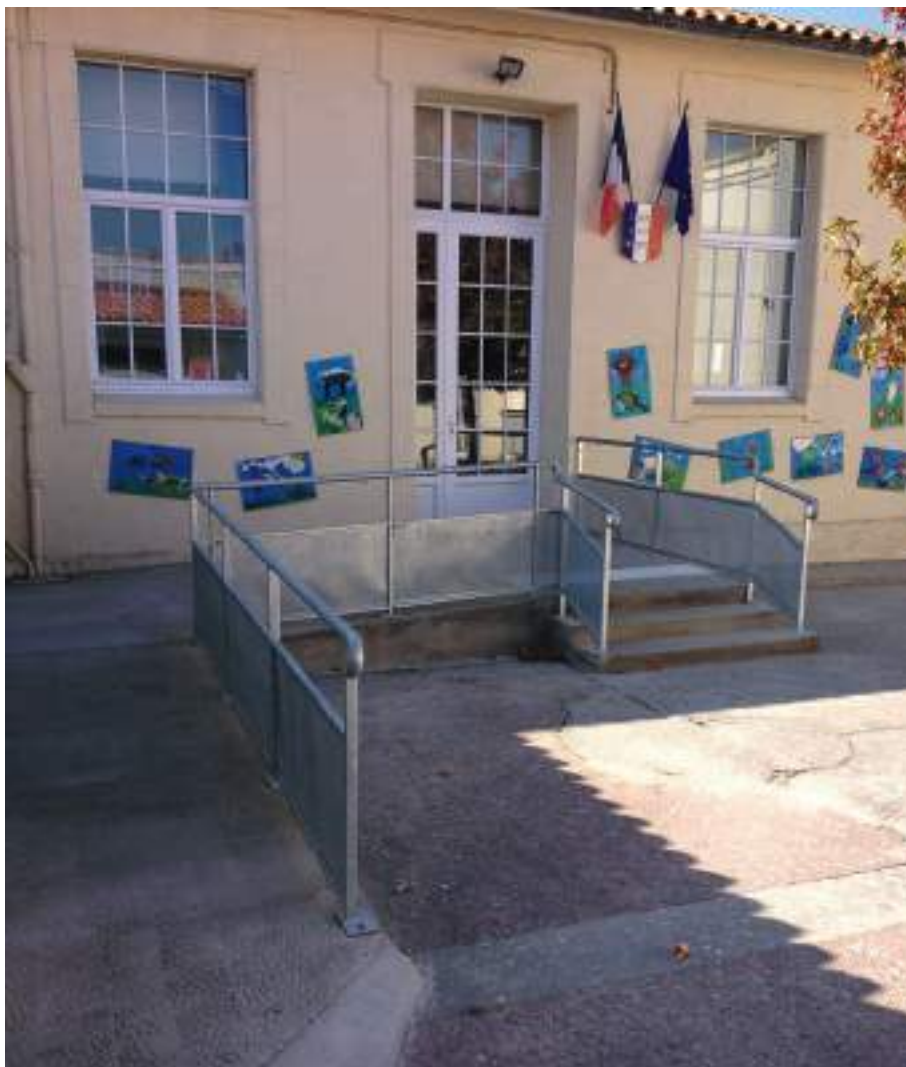
Entrée principale (intérieur cour)
